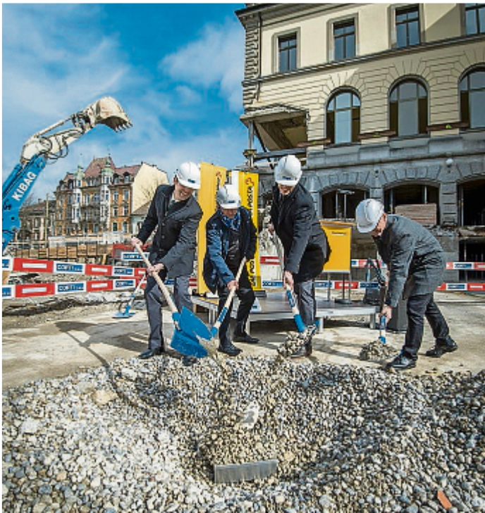
Bild: Reto Martin Anders Stokholm und Co. schaufeln und vergraben den Grundstein.
